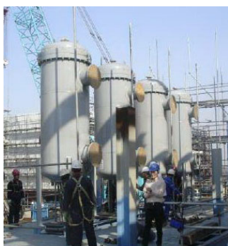
Filtri per acqua di mare in fase di installazione, ciascuno idoneo per portata di 1150 m 3 /h con installate nr. 230 cartucce da 50".
